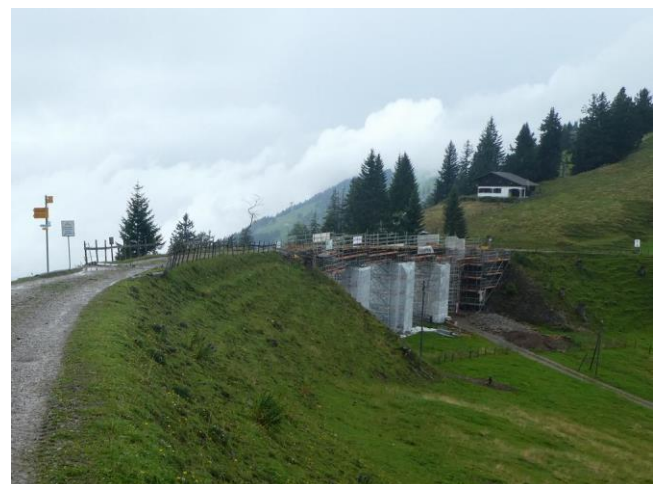
alte Eisenbahnbrücke in Unterstetten
