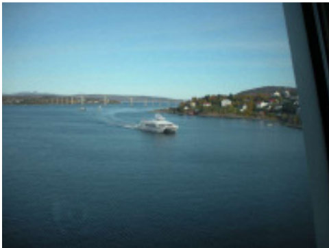
Brücke über den Sund
