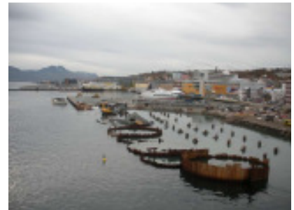
Bauarbeiten im Wasser
