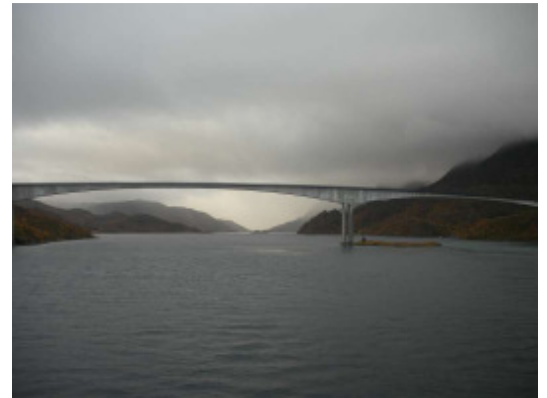
Brücke über den Sund
