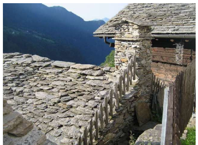
Dach aus Lesesteinen und mit Ziegengitter
