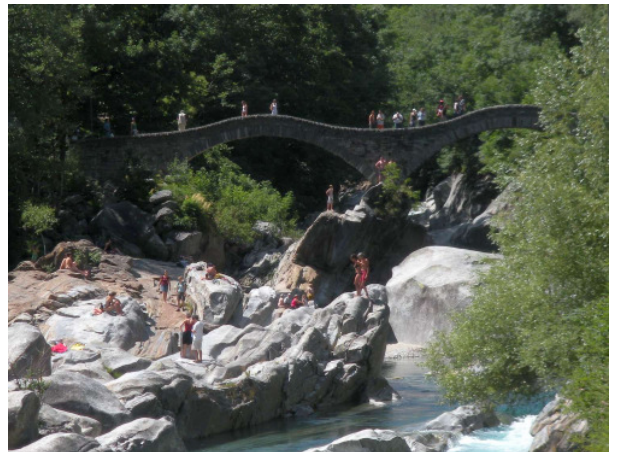
die Brücke bei Lavertezzo
