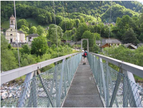
Brücken über die Verzasca
