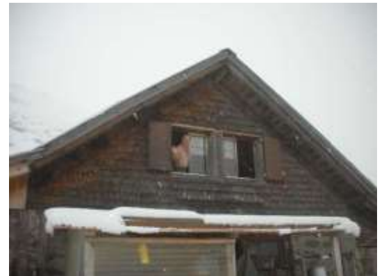
Logis über dem Kuhstall
