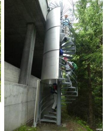
aufs Dach der Galerie
