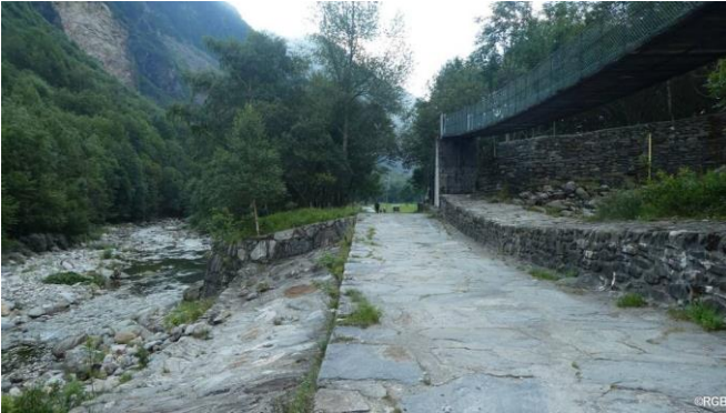
Hängebrücke für alle Fälle
