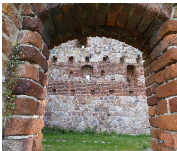
Maurerarbeiten von einst
