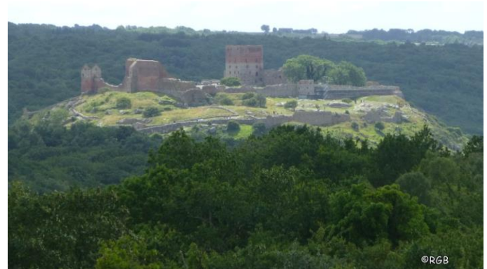
die Ruine Hammershus
