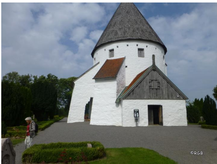
Rundkirche mit den Aussenstützen
