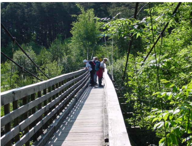
Holzbrücke über den Hinterrhein
