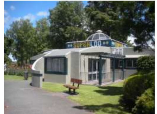
gepflegte, öffentliche Toiletten
