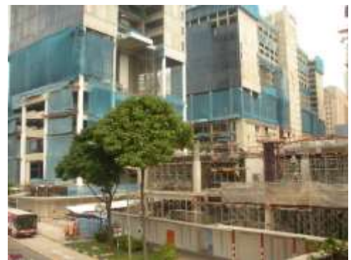
...wird auch gebaut
