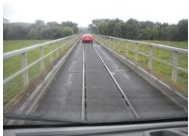
die One-Lane-Bridge mit Schienen
