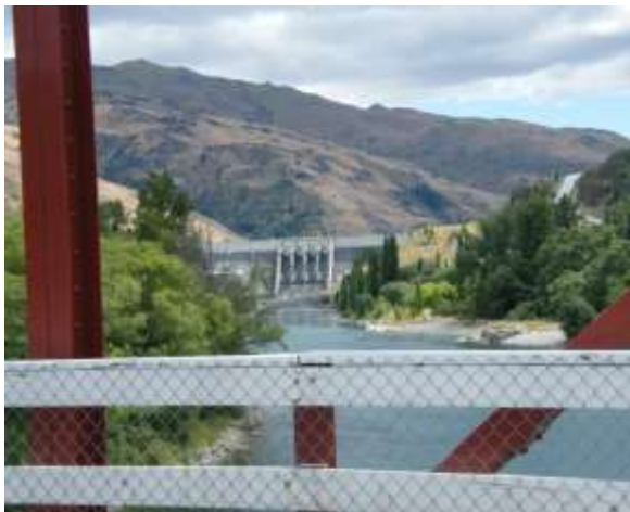
Staudamm von der alten Brücke aus
