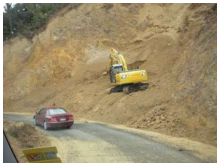
noch voll im Bau
