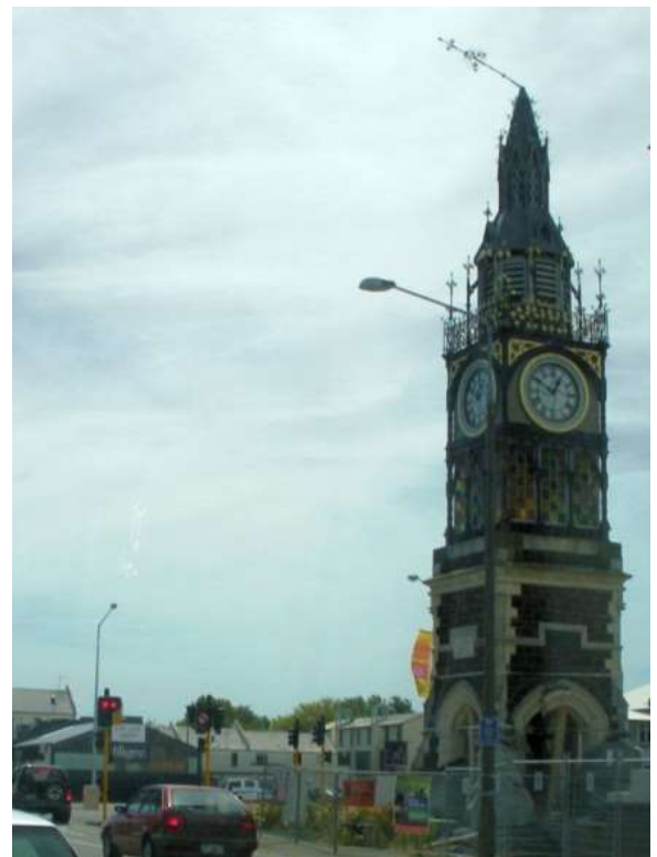
vom Erdbeben lädiertes Kirchturm
