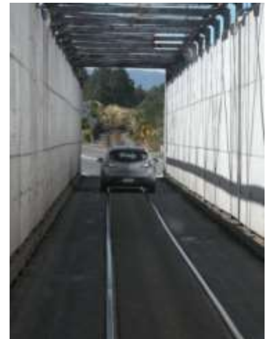
One Lane Bridge mit Schienen
