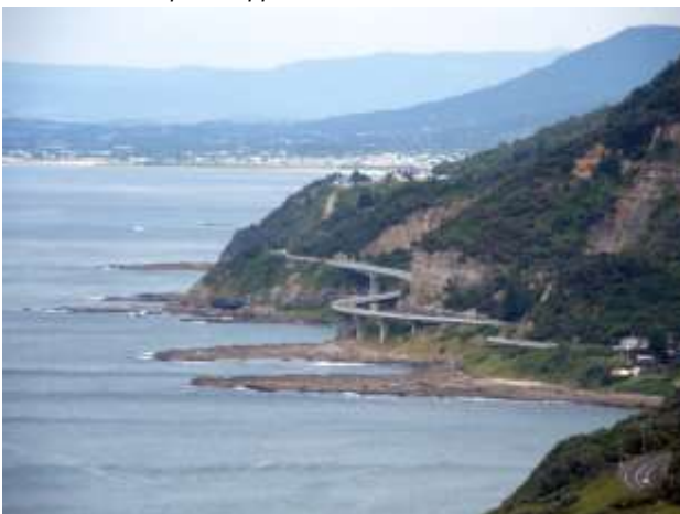
die Sea Cliff Bridge
