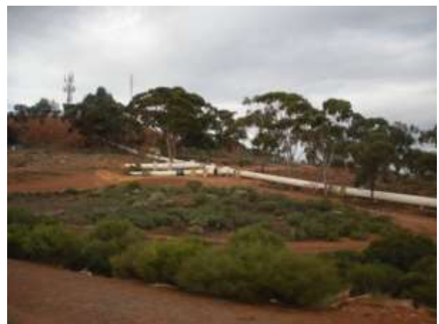
das Wasser kommt in Pipelines aus Perth ins Reservoir
