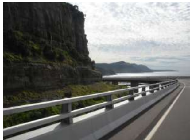
auf der Sea Cliff Bridge
