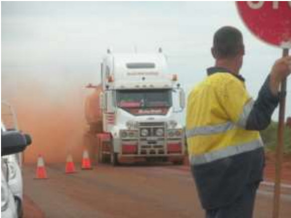
Strassenbaustellen mit Lollipop-Boys
