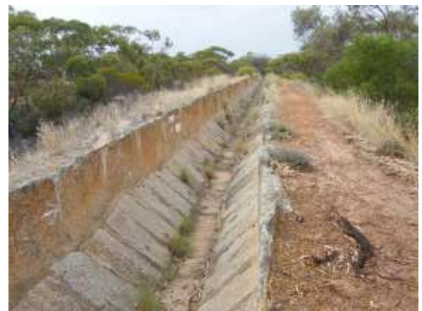
und Abflusskanal zum Reservoir
