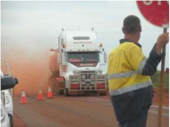
Strassenbaustellen mit Lollipop-Boys
