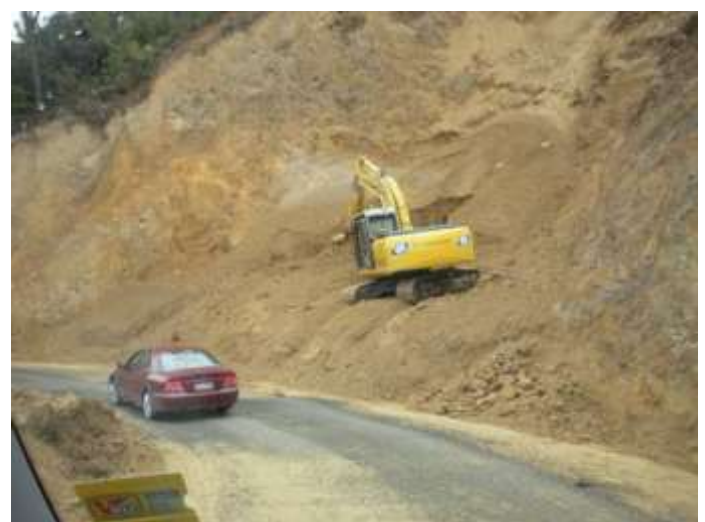
noch voll im Bau
