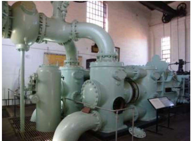
die dritte von 8 ehemaligen Pumpstationen zwischen Perth und Kalgoorlie
