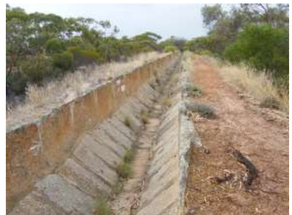
und Abflusskanal zum Reservoir
