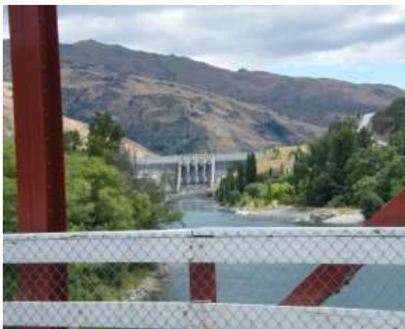
Staudamm von der alten Brücke aus
