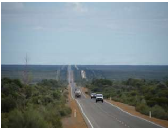
Elektrisch, Strasse und Wasserpipeline
