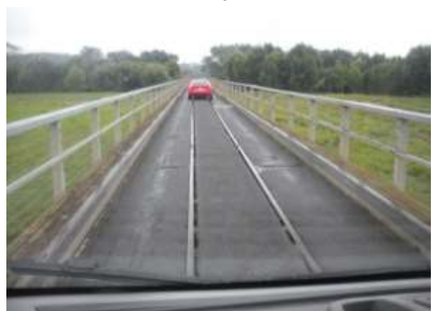
die One-Lane-Bridge mit Schienen
