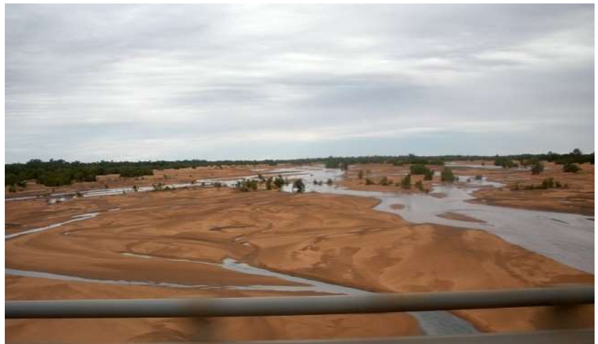
über weite Brücken
