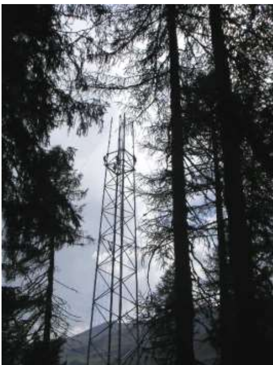
Eine neue Hochspannungsleitung entsteht
